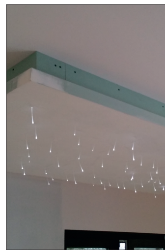
Deckensegel mit Beleuchtung im Bad mit Sternenhimmel nach der Montage.
