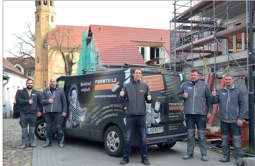
Trockenbauer mit Erfahrung: Ringo Ostwald (3. v. l.) führt mit seinem Team den Trockenbau im „Alten Krug“ in Woltersdorf Region aus. Fotos: Reinhard Witteck (2), Trockenbau Ostwald
